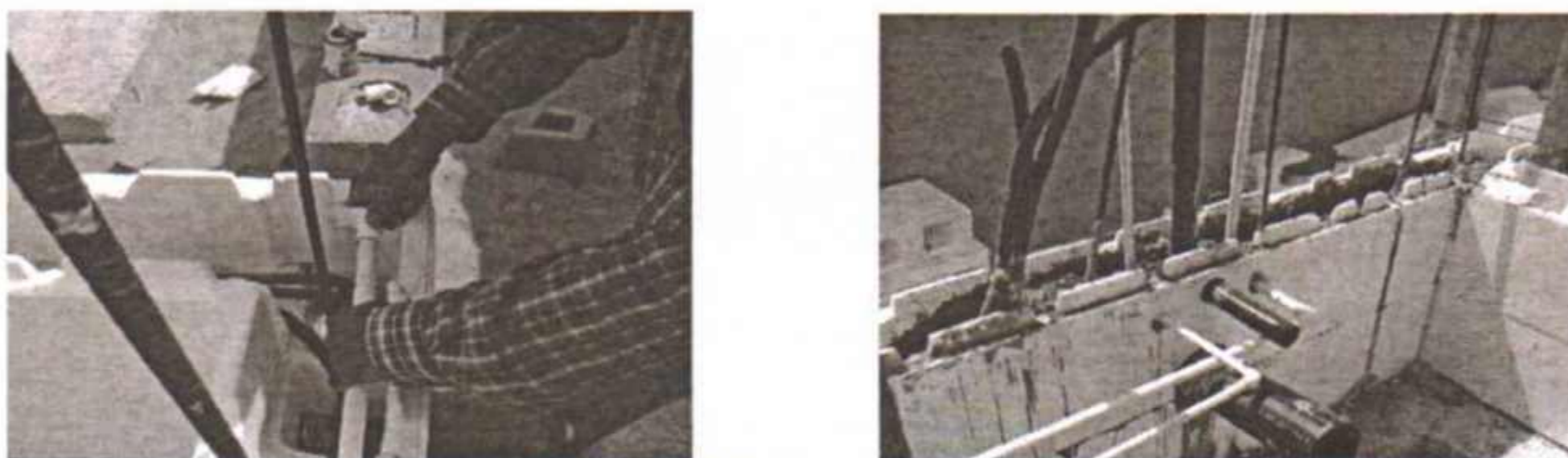
Figura 5 Colocación de instalaciones
